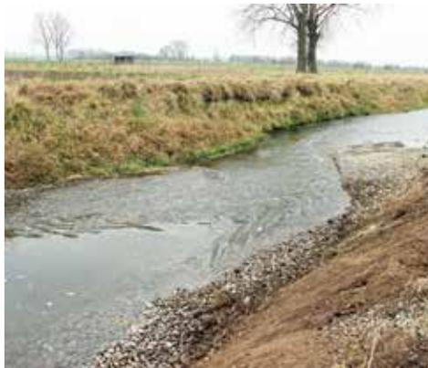
Kiesdepot und Rohboden in der Fuhse bei Woltwiesche kurz nach Fertigstellung.
