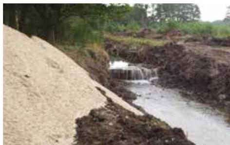
Die letzte Staustufe wird entnommen, bevor mit einem Kies-Sand-Gemisch die Mittelwasserrinne ausgearbeitet wird.
