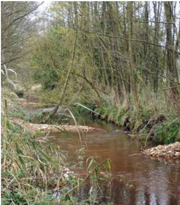
Durch den Einbau von Strömungskernen, Kiesbetten und -depots wurde im Gohbach Struktur- und Strömungsvielfalt geschaffen.
