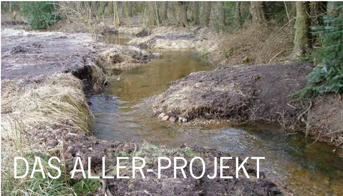
Der Sohlabsturz (ehemals oben im Foto) wurde zu einer naturnahen Sohlgleite umgebaut und der gradlinige Verlauf des Mühlenbaches in Abschnitten naturnah entwickelt.
