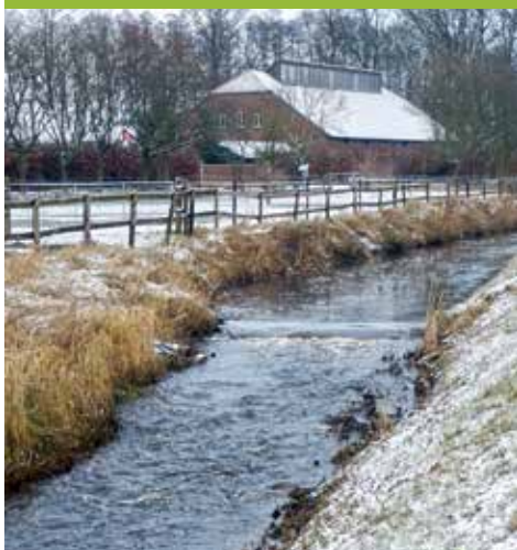
Einer von drei Sohlabstürzen im Gohbach bei Kükenmoor vor dem Umbau.
