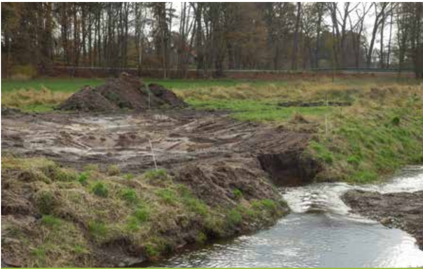
Blänken und Strömungslenker sollen die Lebensraumvielfalt in der Aue und im Gohbach erhöhen.
