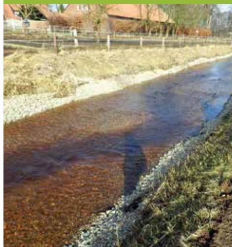
In der neu angelegten Sohlgleite erkennt man die geschlängelte Niedrigwasserrinne.
