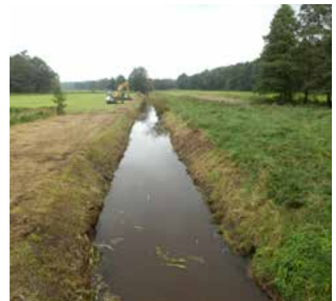
Der Gohbach in Kohlenförde war geprägt durch ein einheitliches Trapezprofil und ein laminares Strömungsbild. Rechts im Bild ist die Pachtfläche zu erkennen.
