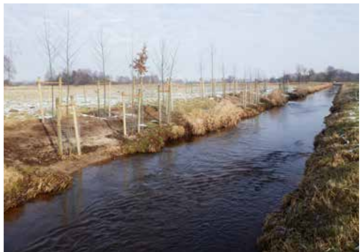
Die Teststrecke hat sich gut entwickelt. Bei höheren Wasserständen wird der Kies überspült und hat keinen Einfluss auf den Wasserstand.
