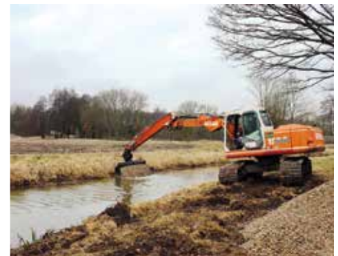
Mit dem Bagger wurden wechselseitig Kiesbänke in die Burgdorfer Aue eingebracht.
