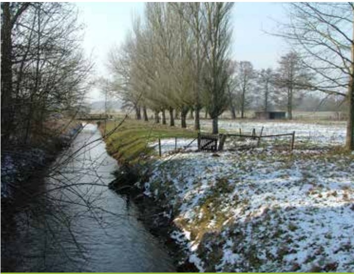
Die Kleine Aller an der Brackstedter Mühle war vor der Maßnahmenumsetzung stark begradigt und ausgebaut.
