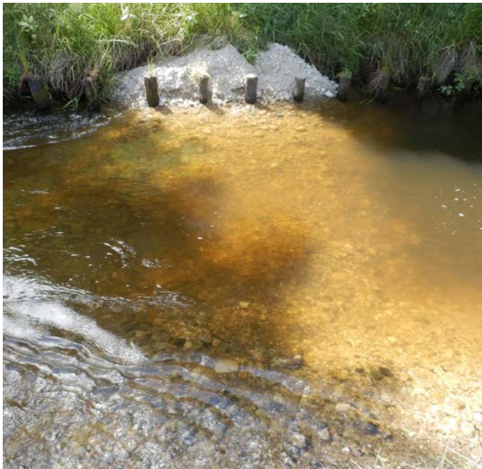
Kiesrauschen im Unterlauf der Lachte verbessern die Struktur- und Strömungsvielfalt.
