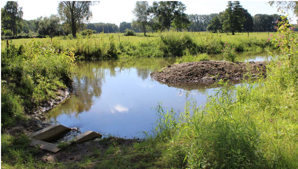
Das neue Einlaufbauwerk mit dem Leitdamm und Blick auf die Fuhse.
