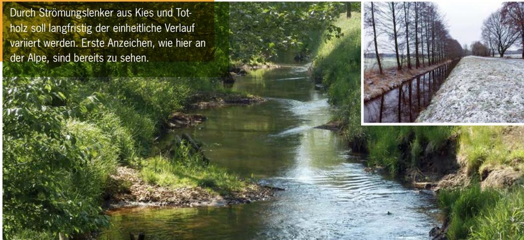
Wo die Möglichkeit bestand, wurde auch die eigendynamische Entwicklung des Gewässers unterstützt. Mit Strömunglenkern aus Kies oder Totholz wurde die Strömung an das gegenüberliegende Ufer gelenkt und gezielt eine Veränderung des Gewässerverlaufs gefördert, wie an Gohbach, Fuhse und Alpe.
