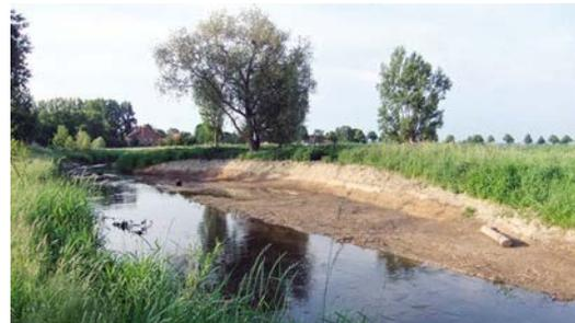
Um wieder eine Wechselwirkung zwischen Gewässer und Aue zu ermöglichen, wurden die Ufer zum Teil abgeflacht oder Sekundärauen ausgebildet, wie an der Fuhse.
