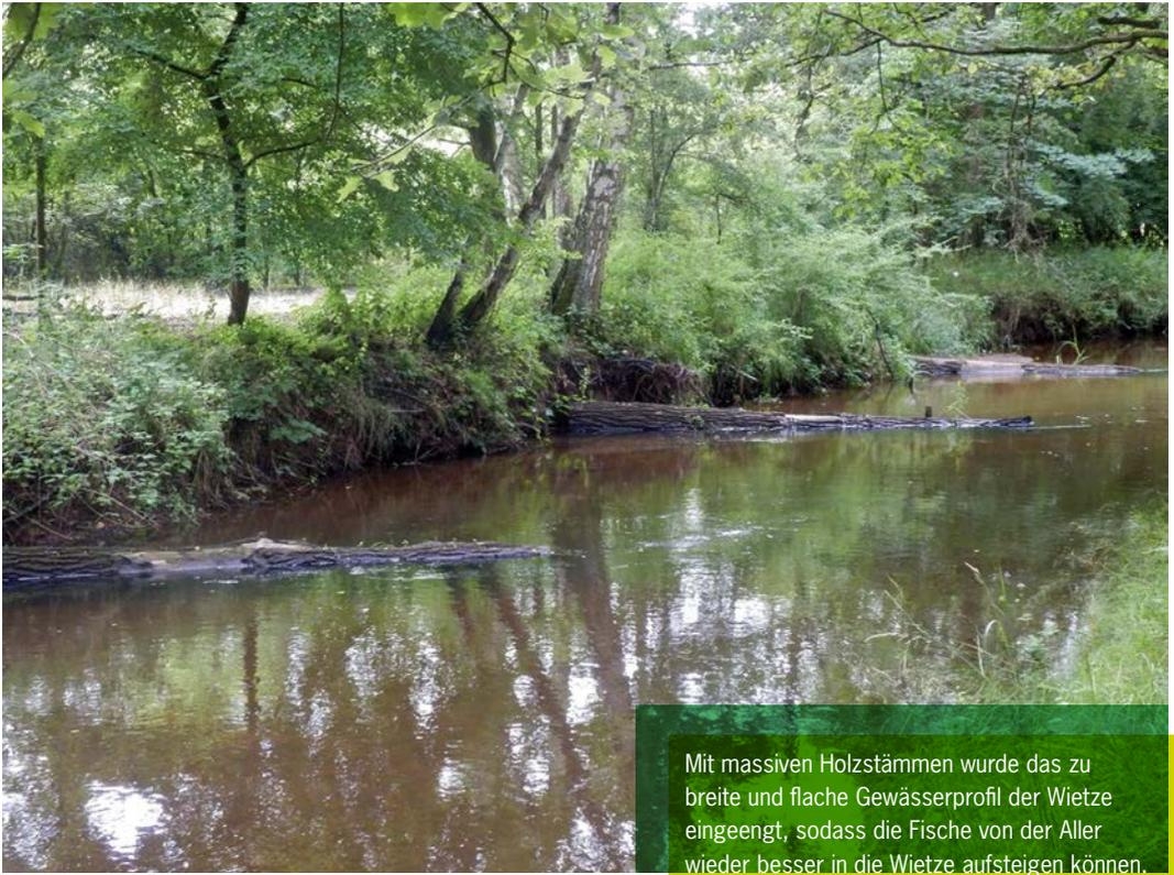
Mit massiven Holzstämmen wurde das zu breite und flache Gewässerprofil der Wietze eingengt, sodass die Fische von der Aller wieder besser in die Wietze aufsteigen können.
