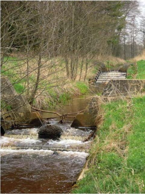
Der Umbau der beiden Pfeifenbringschen Abstürze am Gohbach, mit einem Höhenunterschied von insgesamt 1,70 m, wurde wissenschaftlich begleitet. Anhand einer Elektrobefischung wurden die Fischbestände vor und nach der Maßnahmenumsetzung erfasst. Dafür wurden sie kurz betäubt, bestimmt, ausgezählt und wieder ins Wasser gesetzt.
