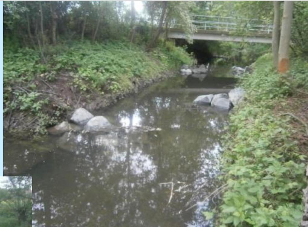
Störsteine und Sohlkies nach Ausbau der Ufersicherung
