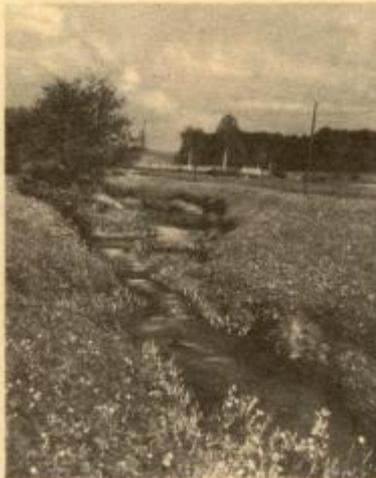
**Nachteile:** Die Sträucher in der Böschung haben bei Hochwasser den Abflußquerschnitt eingengt und Schäden am anderen Ufer verursacht.
