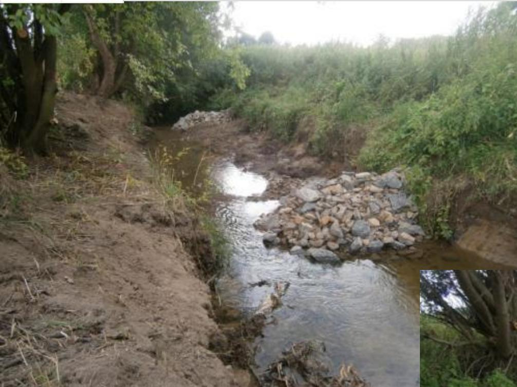
5. Maßnahmen zur Verbesserung der Sohlstrukturen durch den Einbau von Festsubstraten
