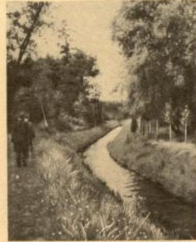
**Vorteile:** Der Querschnitt des Wasserlaufes ist durch Anpflanzungen nicht eingengt. Das Hochwasser erfährt keine Ablenkungen und wird die Böschungen nicht ausspülen.
