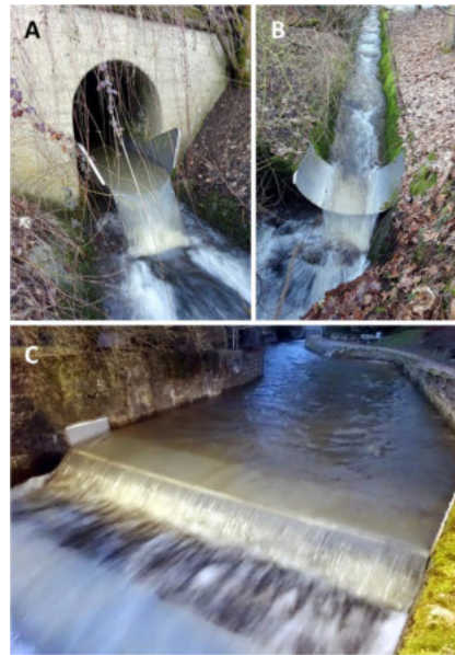
Verschiedene Vollsperrungen in ad hoc Bauweise (A – Finsterbach, BW; B – Zieggraben, BW; und C – Kander, BW). Die Sperrungen wurden jeweils auf vorhandene Strukturen aufgesetzt. Für A wurde der Absturz neu erzeugt. © C. Chucholl. Aus: Erstellung einer Expertise zu Krebsperren und alternativen Schutzmaßnahmen für den Steinkrebs - Hessisches Landesamt für Naturschutz, Umwelt und Geologie
